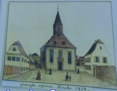
franzö. reform. Kirche 1854. Die Kirche vorne Fassade auf
